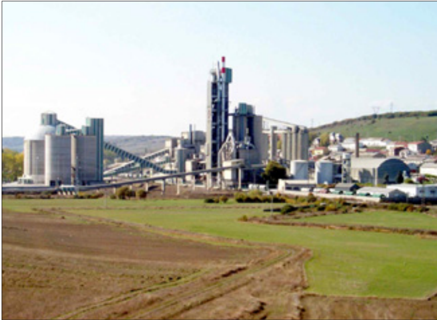
Instalaciones de complejo industrial de Cementos Alfa en Mataporquera.
