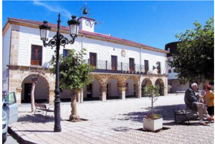
Las obras de la Casa Consistorial acabaron en febrero pasado y desde entonces se trabaja en su equipamiento.
