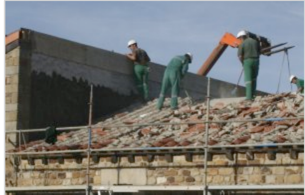
Operarios, en el tejado renovando la cubierta. :: J. L. S.
