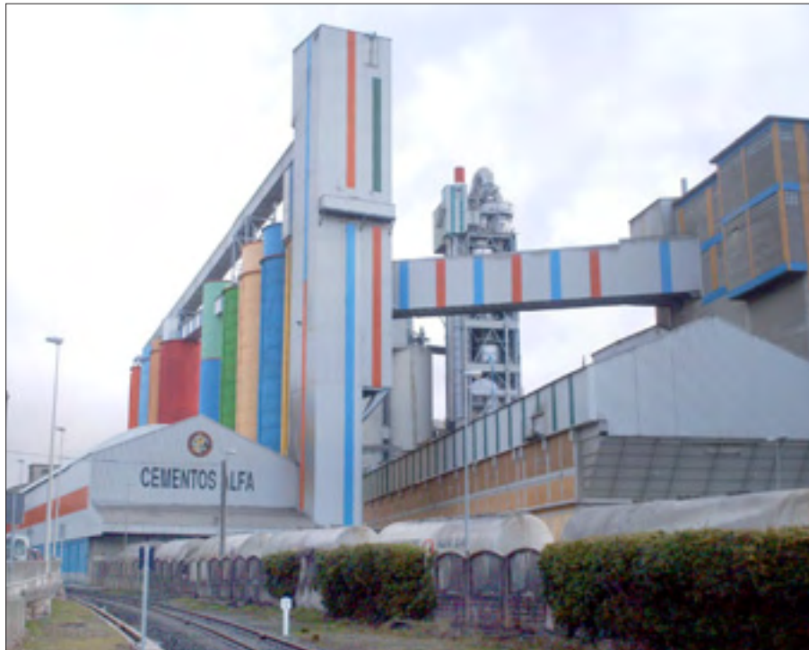
Instalaciones de Cementos Alfa en Mataporquera.
