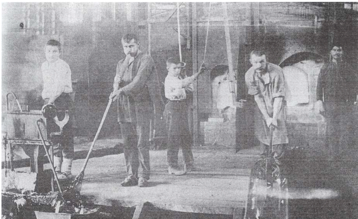
Vemos junto al horno al garmín que abría y cerraba la puerta del horno. El levantador que formaba la posta en la punta de la caña y los sopladores, uno de vidrio hueco y otro de manchones que luego se cortaban para hacer vidrio plano.
